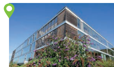
L'EHPAD Les Verdannes Évian-les-Bains
